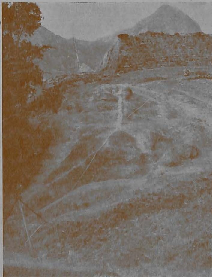
Figura 28. Vista del "Castillo" desde el lugar, donde se piensa instalar la turbina. La huincha indica aproximadamente el trazado de la futura tubería de presión.
