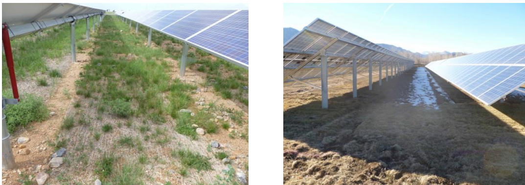
Figura 31 (Izquierda) Conjunto de trackers dispuestos en filas de Norte a Sur, permiten entrada del sol al suelo, área sombreada varía a lo largo del día. (Derecha) Conjunto de paneles fijos, dispuestos en filas de Este a Oeste, maximizando el efecto de sombreado. Fuente: David Buckner. Native Vegetation Performance under a Solar PV Array at the National Wind Technology Center. (National Renewable Energy Laboratory, 2017)
