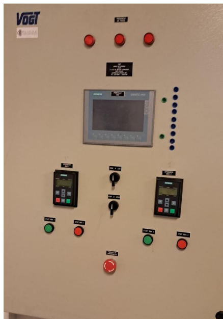
Figura 4.12: Pantalla HMI juntos con los controladores de ambos variadores de frecuencia.
