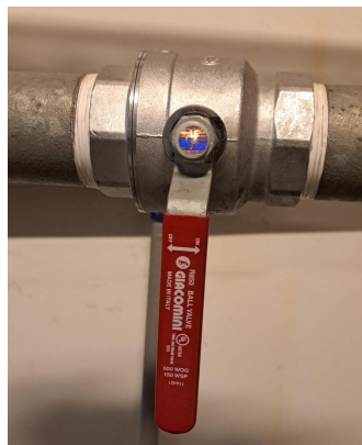
Figura 4.4: válvula de bola Giacomini R850.
