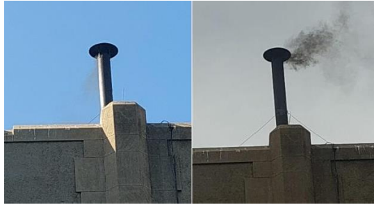
Figura 34: Emisiones de escape a misma operación a condiciones ambientales distintas
