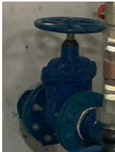
Figura 1-24. Válvula de compuerta
