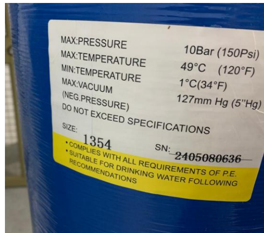
Figura 1-19. Características Técnicas de Hidrotanque V-01
