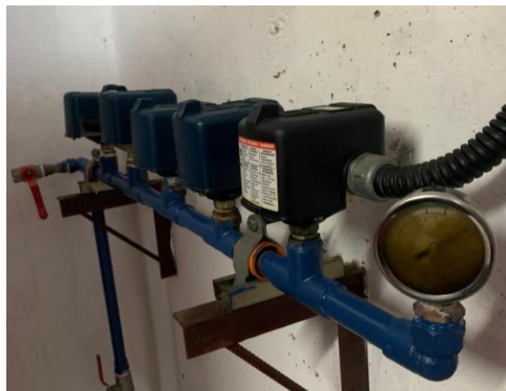
Figura 1-23. Presóstatos Sala de bombas
