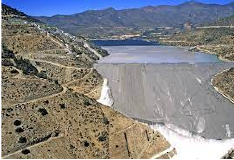
Figura A.10: Tranque El Mauro minera Los Pelambres (Pelambres, 2023).
