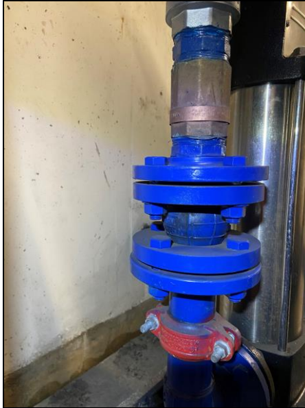
Figura 1-7: Junta de dilatación.
