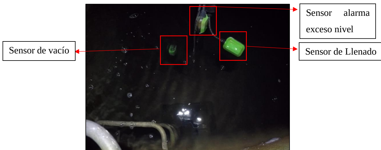
Figura 1-5: Sensores, estanque de agua.
