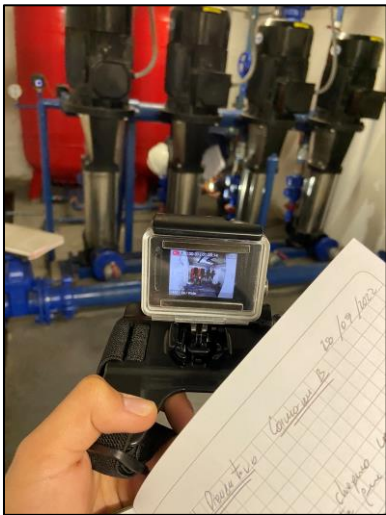
Figura 1-8: Documentación en video de sala de bombas.
