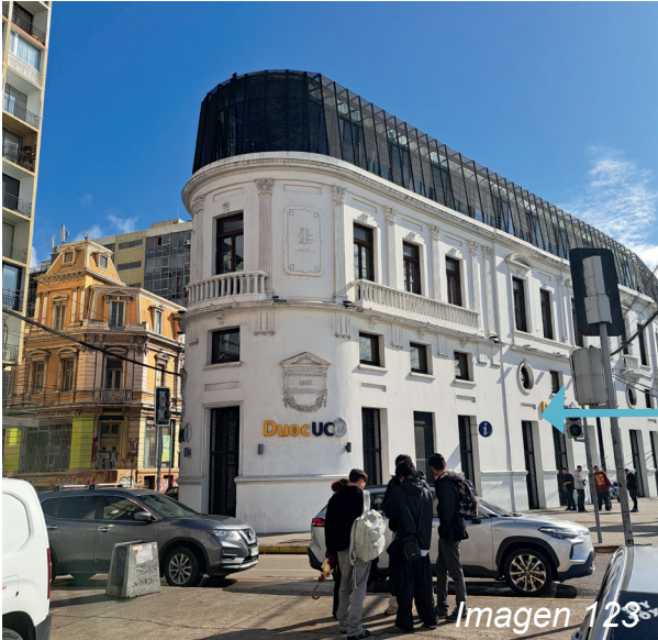
(Vista Fachada DUOC UC edificio Cousiño )
