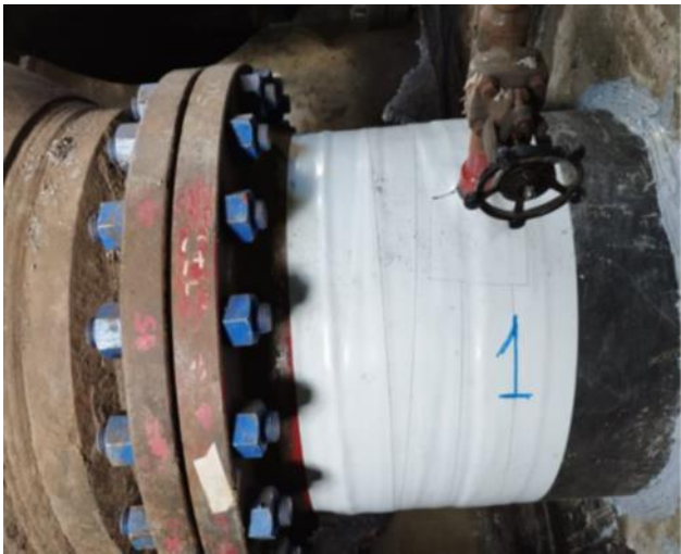
figura 11: Recubrimiento HDPE Fuente: Dossier IPMT
