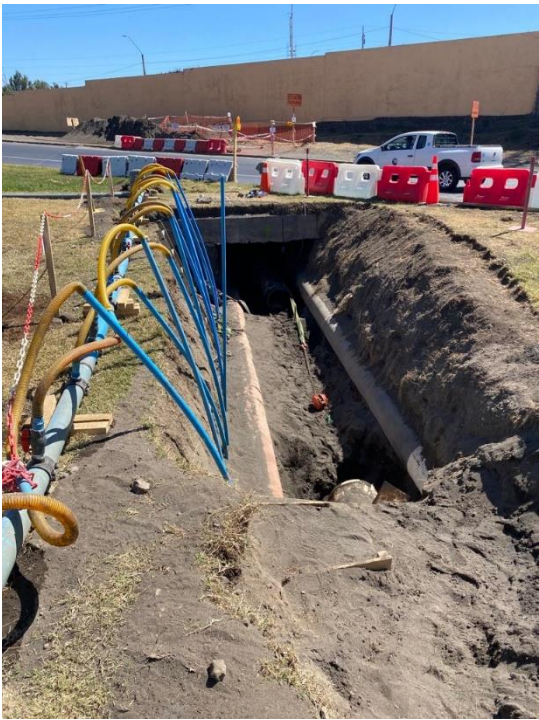
figura 9: Agotamiento de napas con sistema de puntera Fuente: Dossier IPMT
