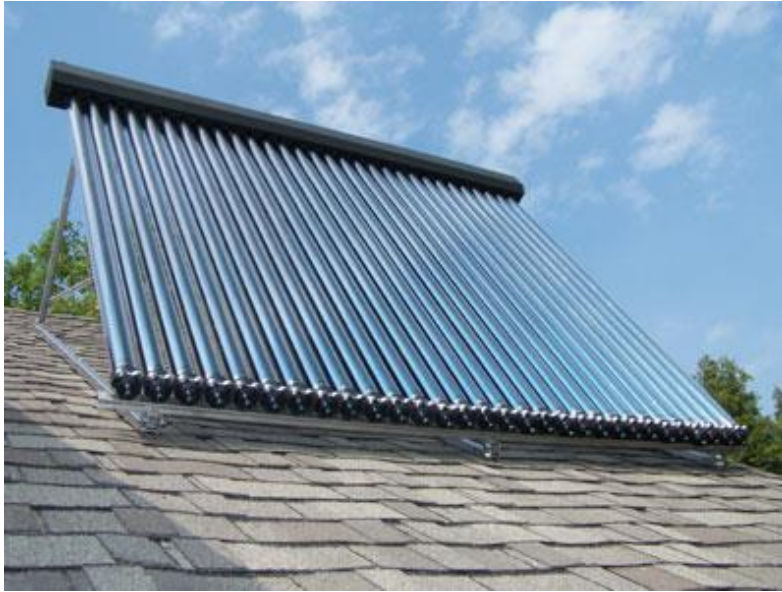
Ilustración 6: Colector de Tubos de Vacío con Heat Pipe en su interior. [4]
