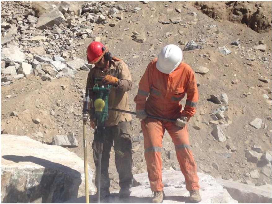
Figura 1-1 proceso de perforación manual.
