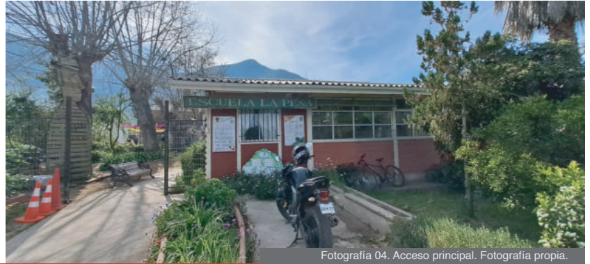
Fotografía 04. Acceso principal. Fotografía propia.
