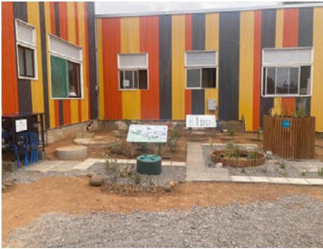
Fotografía 12. Sistemas de reutilización de aguas en Escuela El Yeco. Ecological.
