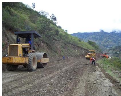
*Figura 60: reconstrucción carpeta, preparacion superficie*
