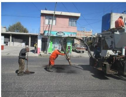
Figura 46: método SPRAY INJECTION, reparación bache
