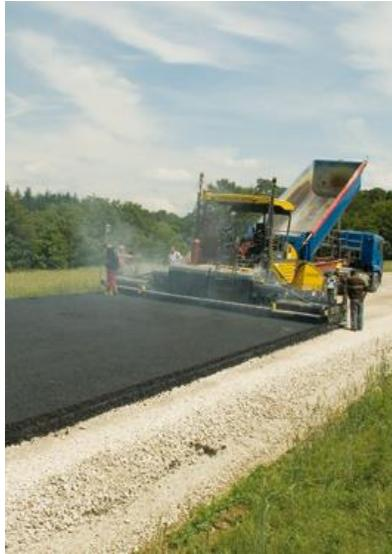
*Figura 64: reconstrucción carpeta, extensión de mezcla*
