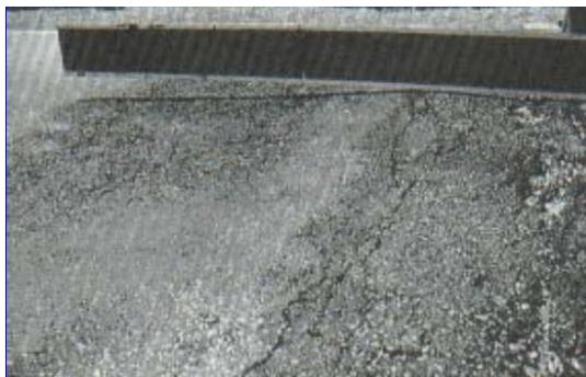
Figura 24: falla grieta de contracción: severidad alta
