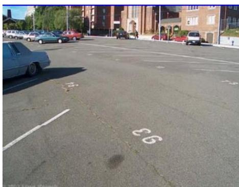
*Figura 28: falla grietas de borde, severidad baja*
