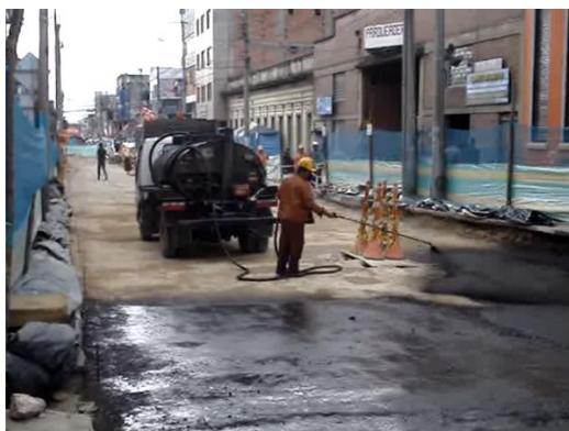
*Figura 62: reconstrucción carpeta, imprimación*
