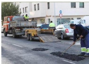
*Figura 41: método EDGE SEAL, reparación bache*
