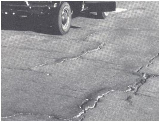
*Figura 21: falla grieta de contracción: severidad alta*
