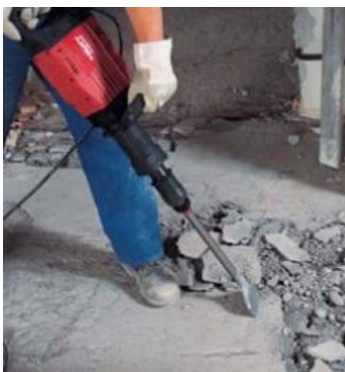
Figura 49: método SEMI-PERMANENT, reparación bache
