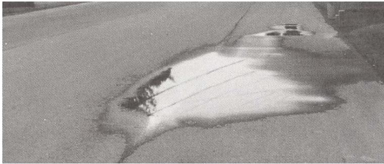
*Figura 25: falla depresión, severidad baja*
