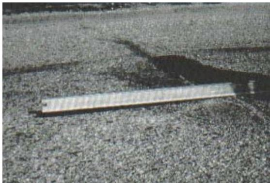
*Figura 22: falla de elevación; hundimiento, severidad baja*
