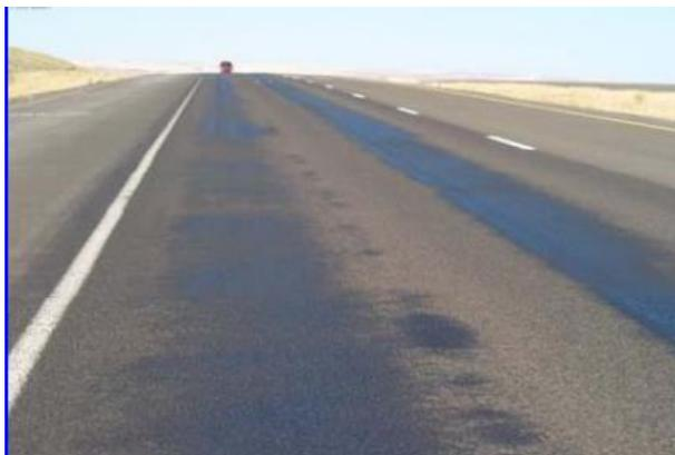
*Figura 17: falla exudación, severidad media*
