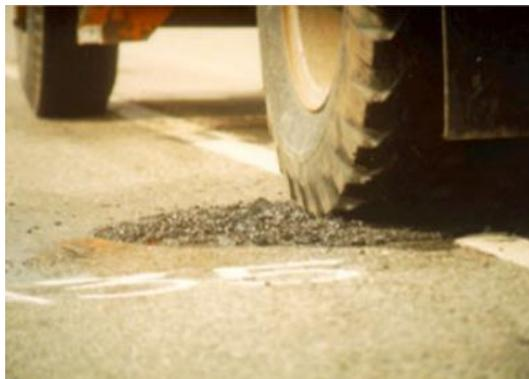
Figura 37: método THROW AND ROLL, reparación bache
