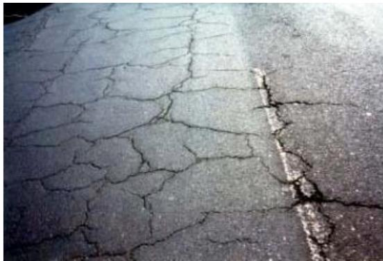
*Figura 20: falla grieta de contracción: severidad media*
