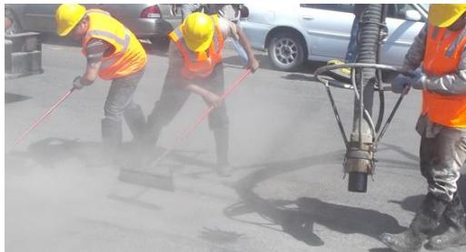
Figura 45: método SPRAY INJECTION, reparación bache
