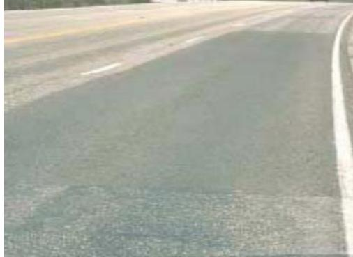
*Figura 31: falla bache, severidad baja*
