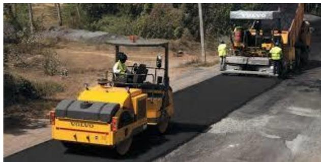
*Figura 65: reconstrucción carpeta, compactación de mezcla*
