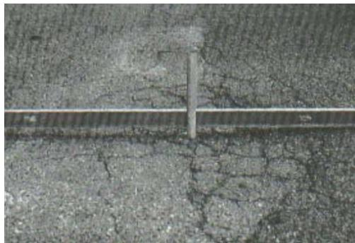
*Figura 26: falla depresión, severidad media*
