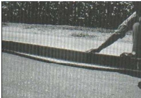
*Figura 27: falla depresión, severidad alta*
