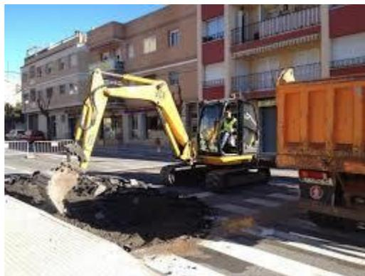
Figura 58: reconstrucción carpeta, escarpe de carpeta
