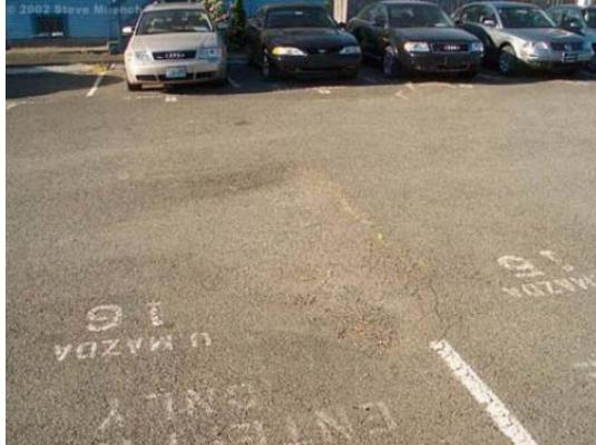
Figura 23: falla grieta de contracción: severidad media
