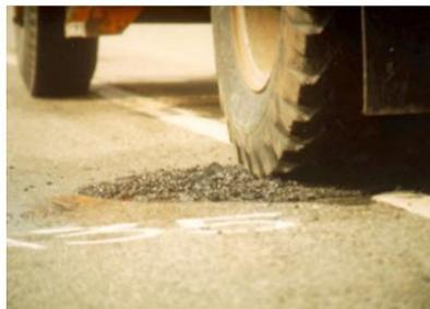
*Figura 40: método EDGE SEAL, reparación bache*
