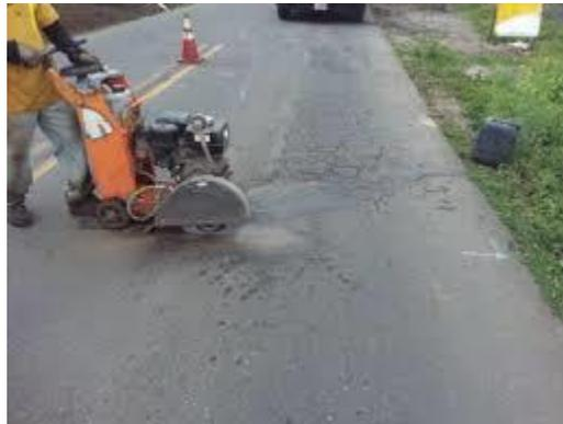
Figura 57: reconstrucción carpeta, trazado
