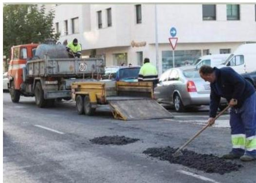
Figura 38: método THROW AND ROLL, reparación bache
