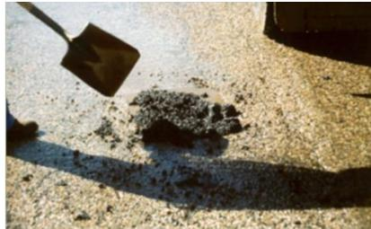
*Figura 39: método EDGE SEAL, reparación bache*
