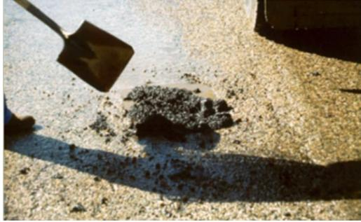
Figura 36: método THROW AND ROLL, reparación bache
