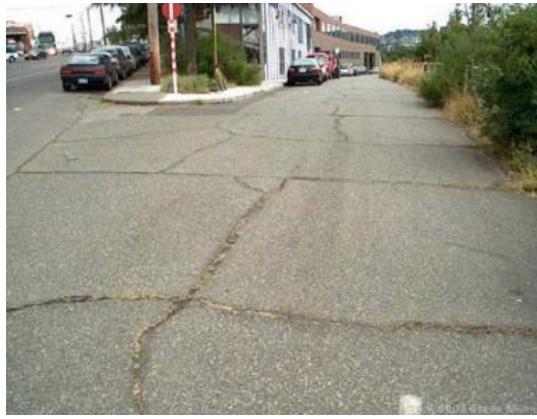
*Figura 30: falla grietas de borde, severidad alta*
