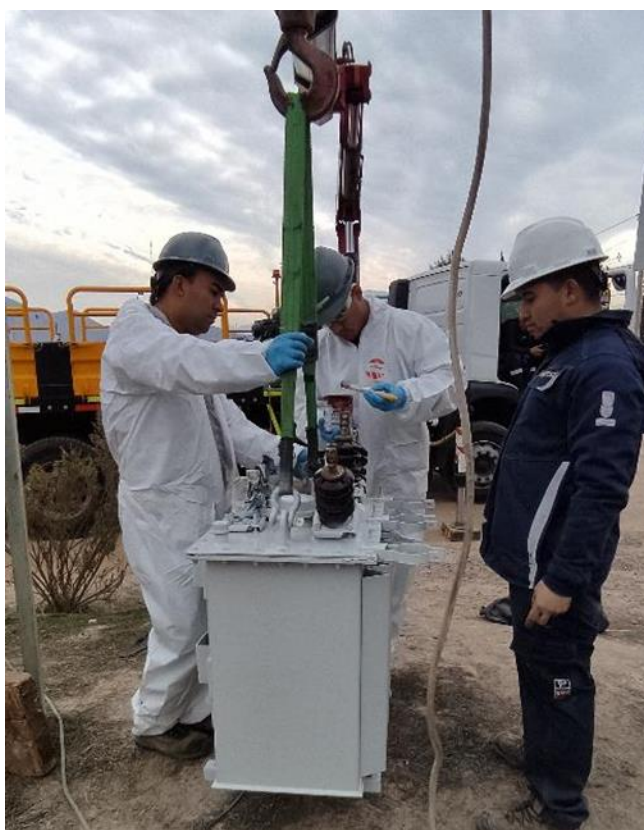
Figura 3.- Mantenimiento de un transformador de distribución
