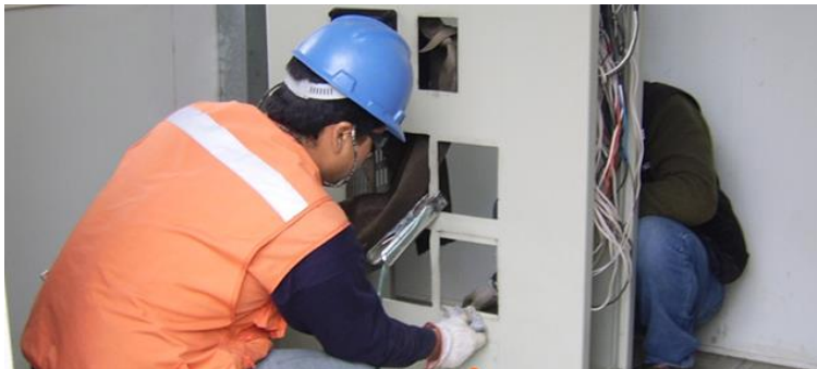
Figura 6.- Personal de UTR realizando mantenimiento de los elementos de telecontrol
