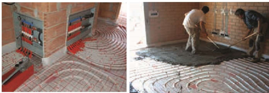
Figura 1-23 Aplicación de mortero
