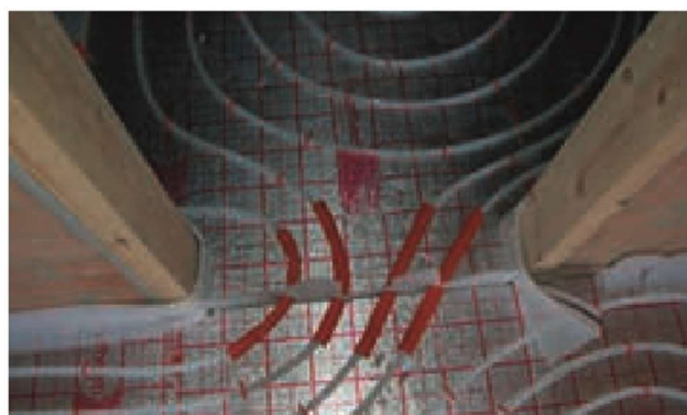
Figura 1-21 Juntas de dilatación
