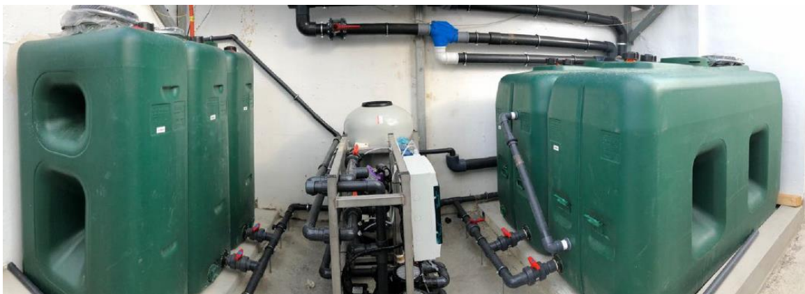
Figura 15. Configuración de un sistema de tratamiento de aguas grises utilizando EcoStep Pro Fuente: Guía de sistemas para reutilización de aguas grises y pluviales
