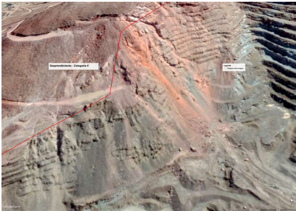
Figura 39: Medición de Desprendimiento de talud Categoría 4 Fuente: Elaboración propia mediante Google Earth Pro
