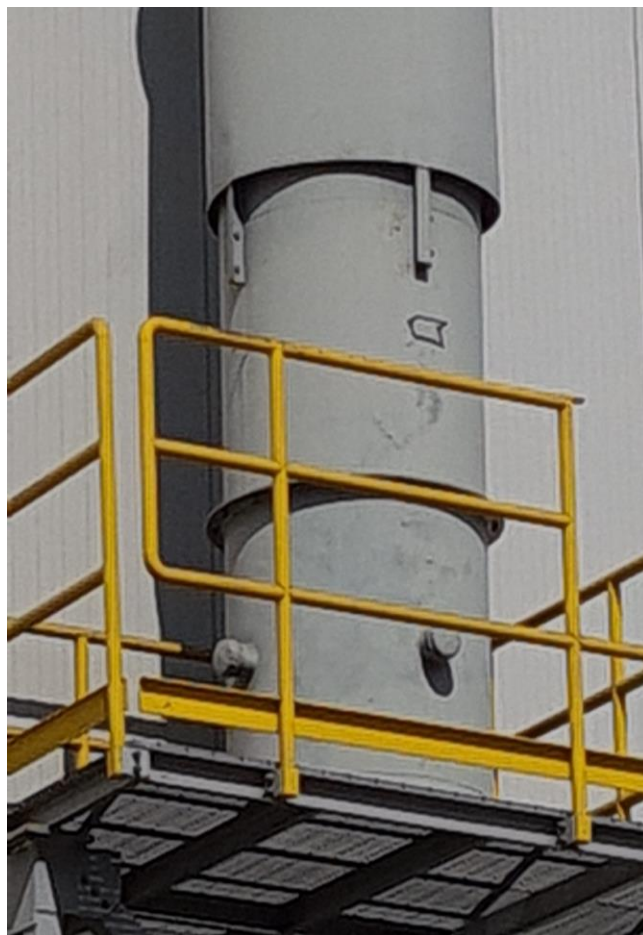
Figura 12: Puertos de muestreo de una fuente estacionaria. Fuente: Elaboración Propia
