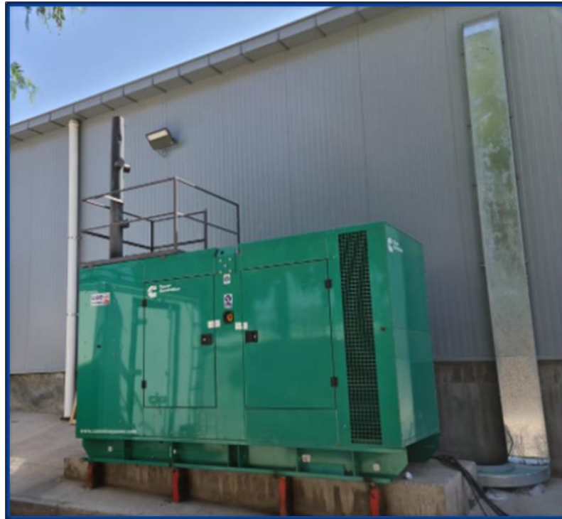
Figura 3: Grupo Electrónico y puertos de muestreo.
