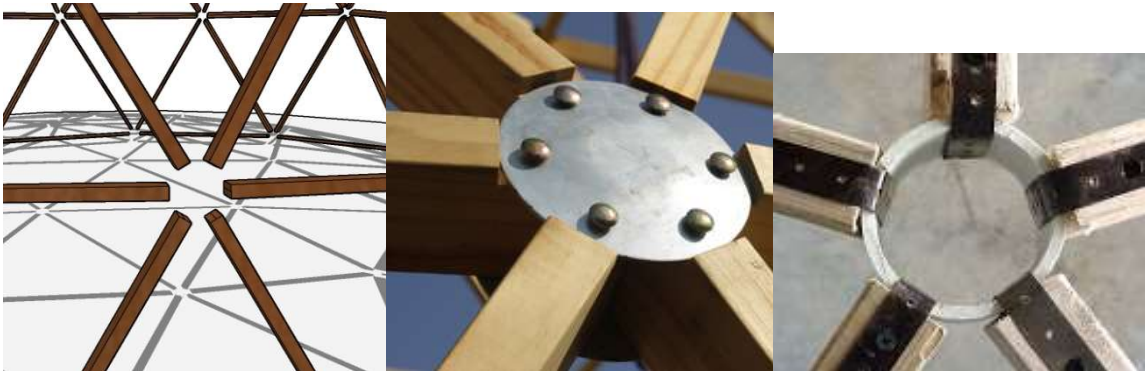
FIGURA: 2-12 CONEXIÓN CANALIZADO FUENTE: OVACEN.COM
