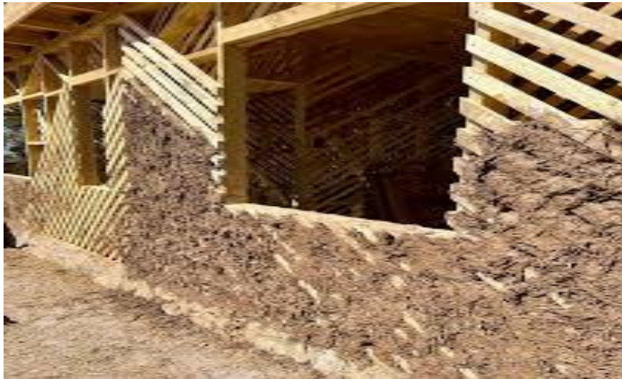
FIGURA 7: CONSTRUCCIÓN EN QUINCHA CONTEMPORANEA
