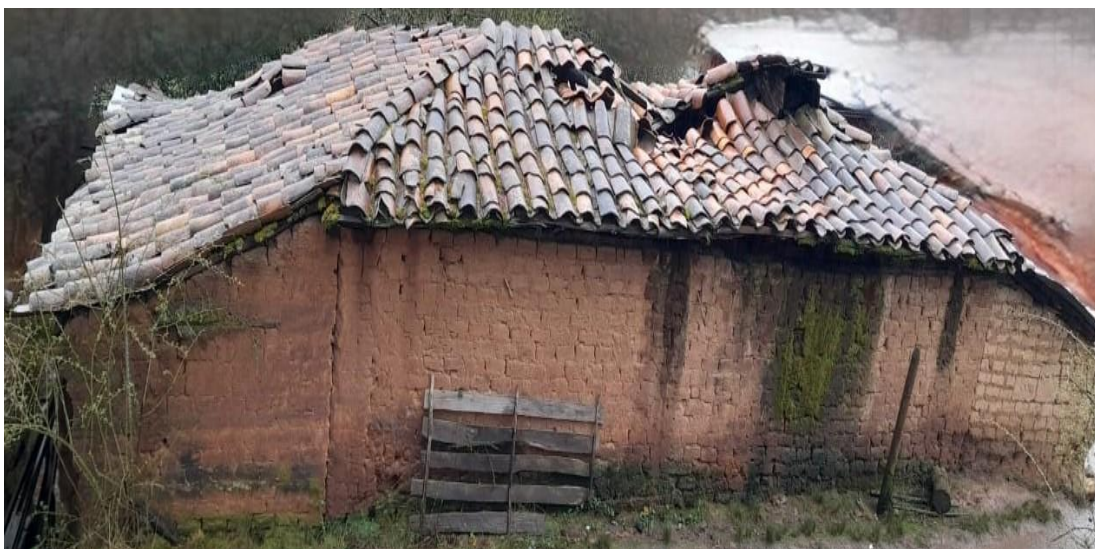
FIGURA 1: VIVIENDA RURAL CONSTRUIDA EN ADOBE
