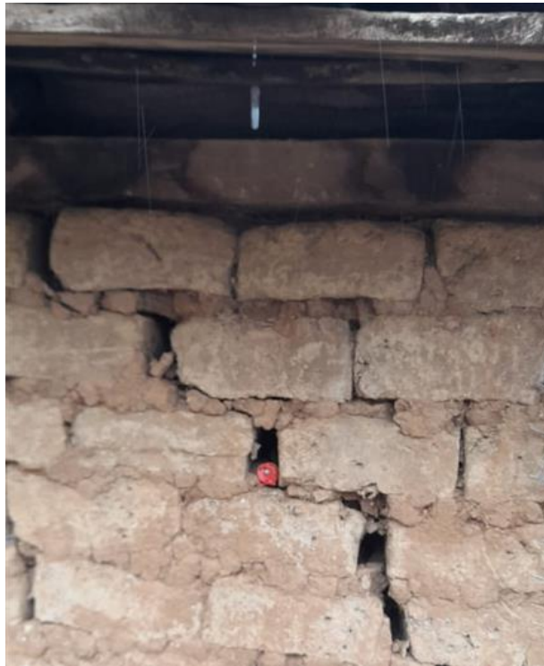
FIGURA 3: DAÑO SISMICO
