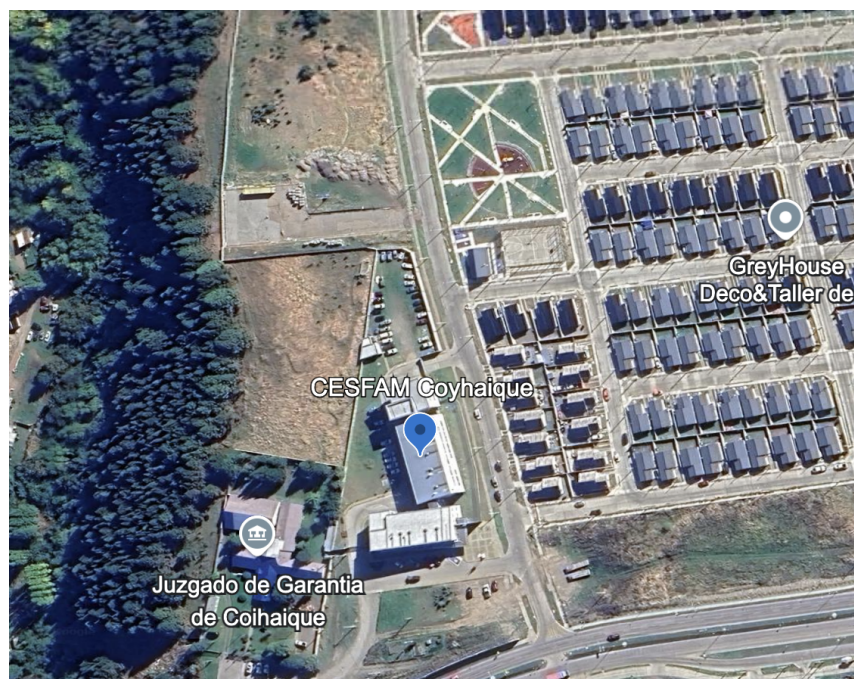
Figura 8.3: Zona de Construcción CESFAM de Coyhaique. (Fuente: Imagen extraída de Google Earth)
