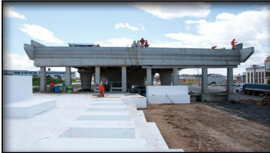
Figura 6.18 Utilización del GEOFOAM como terraplenes ligeros. Aislapol (2019)
