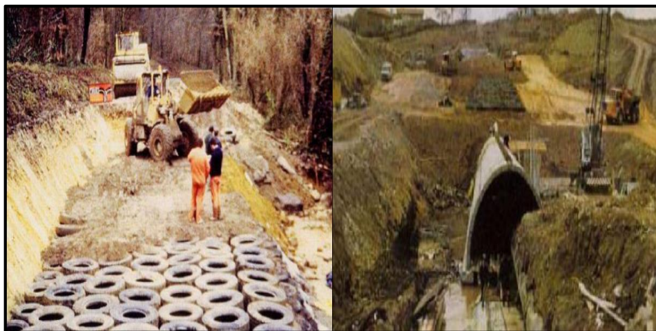
Figura 2.4 Aplicaciones de neumáticos considerando los neumáticos como elemento estructural. Long (1993).
