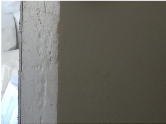
Figura 2.2.3. Muro COTUX sin revestimiento.
