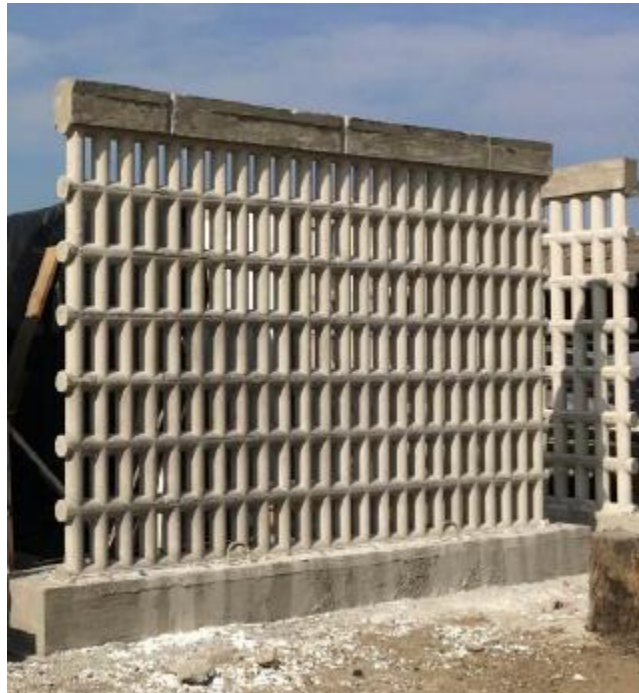
Figura 2.1.2. Interior de hormigón armado de los paneles.
