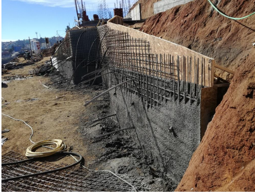
Figura 3.1.9. Ejecución muro atirantado.
