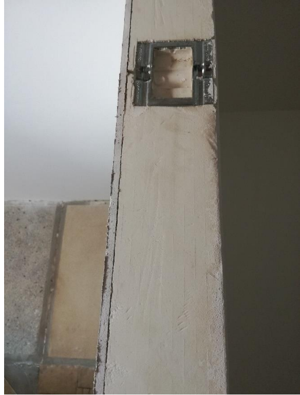
Figura 2.2.2. Detalle sistema de anclaje.
