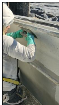
Ilustración 24: Aplicación de la capa inicial de U-Stucco.
