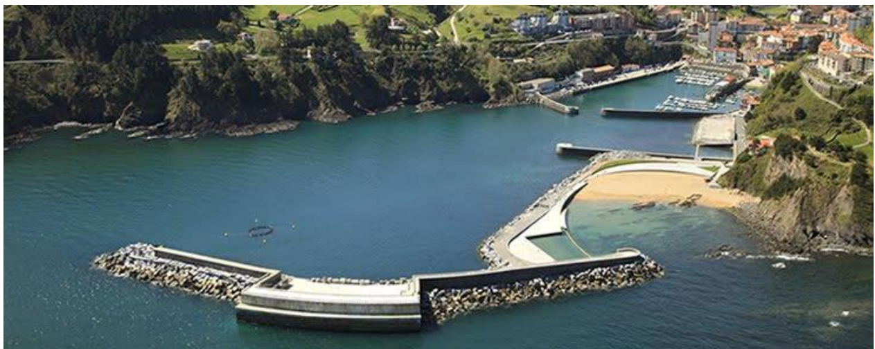
Imagen 3: Central undimotriz Mutriku.
