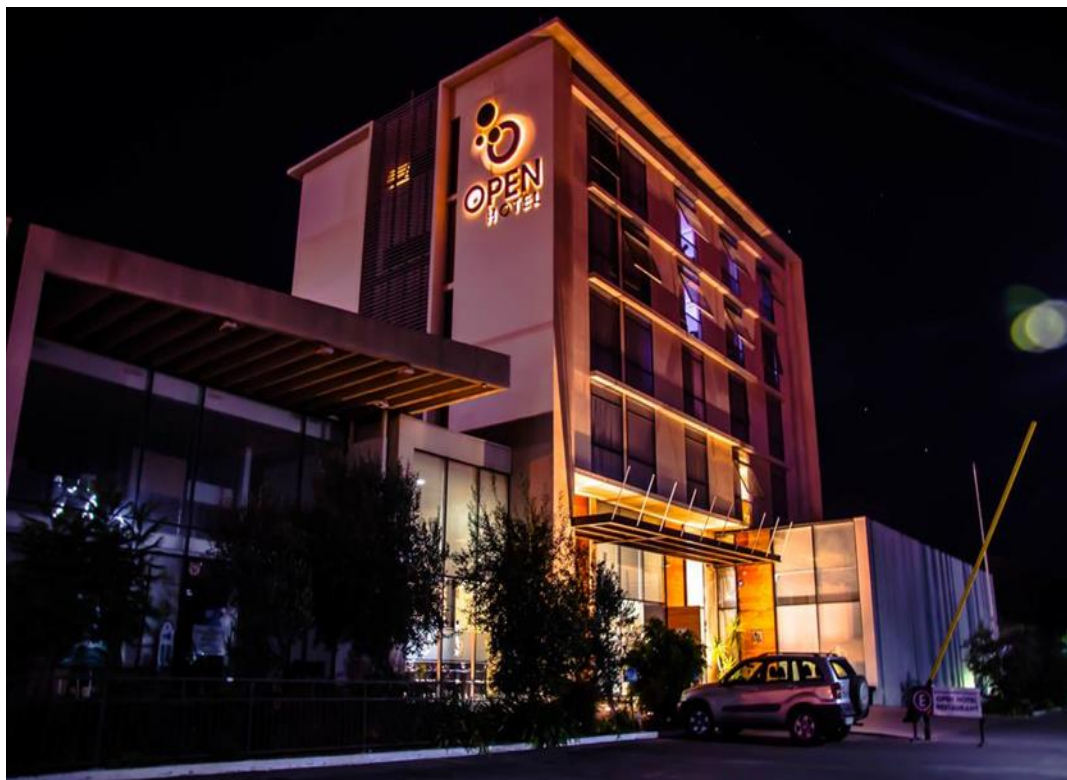
Imagen 5: Fachada Open Hotel Quillota
