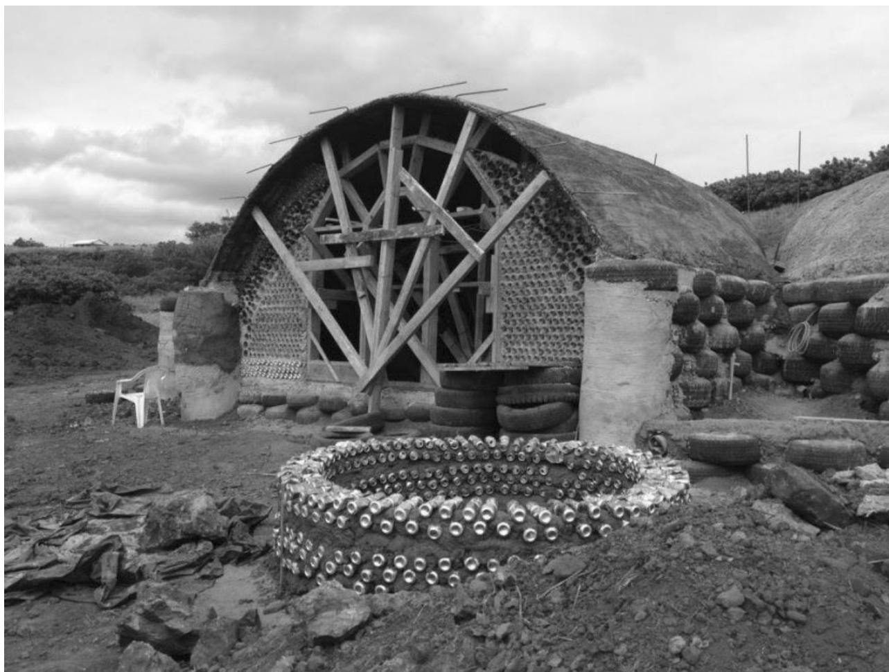
Figura 78. Proceso de construcción Escuela de Música Toki. (s.f). Kurt Castro.
