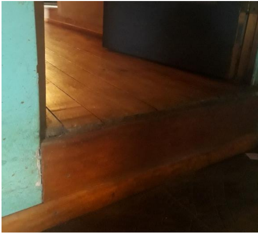
Imagen 1.17-18: Diferencia de nivel en acceso a pasillo y su corte en plano.
