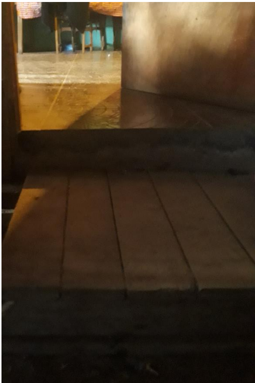
Imagen 1.24-25: Diferencia de nivel en acceso a cocina y su respectivo corte en plano.
