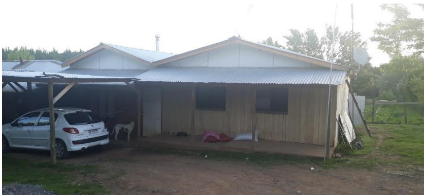
Imagen 1.4: Frontis de vivienda a reacondicionar.
