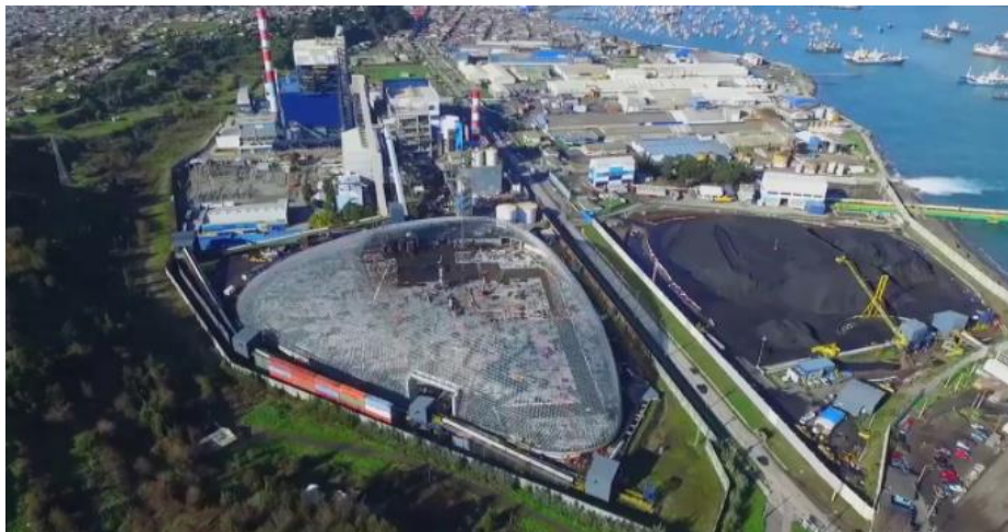
Figura 2. Central Termoeléctrica Bocamina
