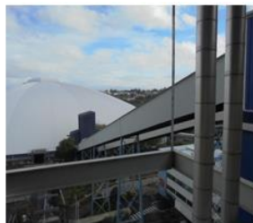
Imagen 1: Estructura Banda transportadora
