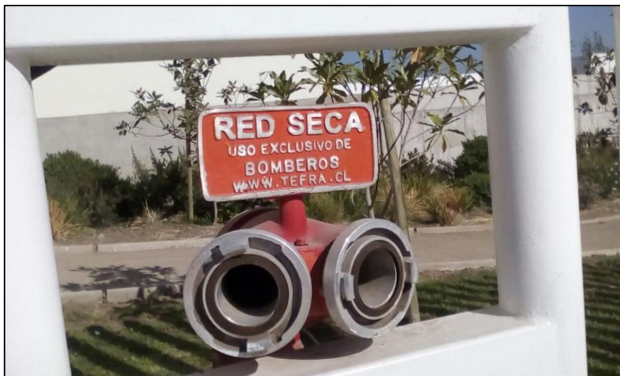
Figura 2: Conexión de bomberos a Red Seca por Vicuña Mackenna.
