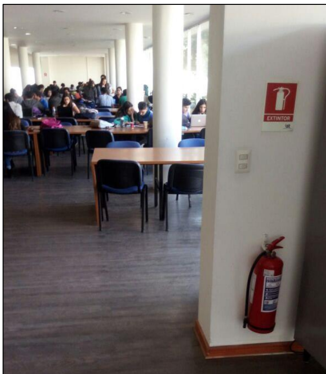
Figura 6: Extintor en sala de estudio.
