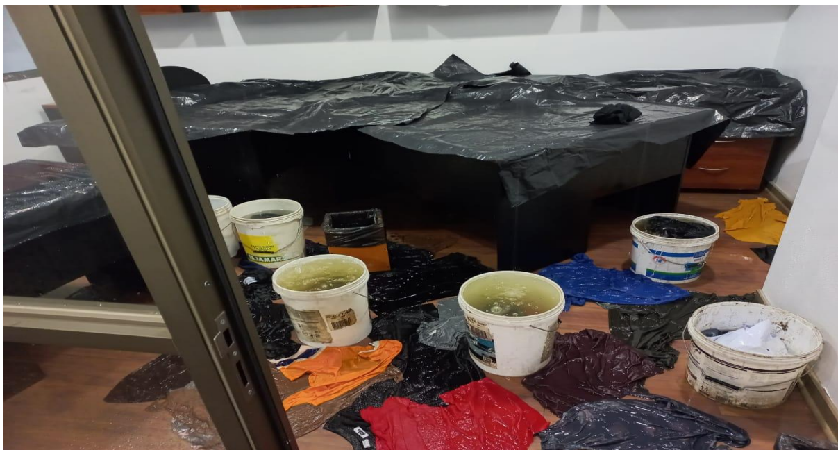
Imagen 22: Filtraciones Oficinas Doctorado de Matemáticas
