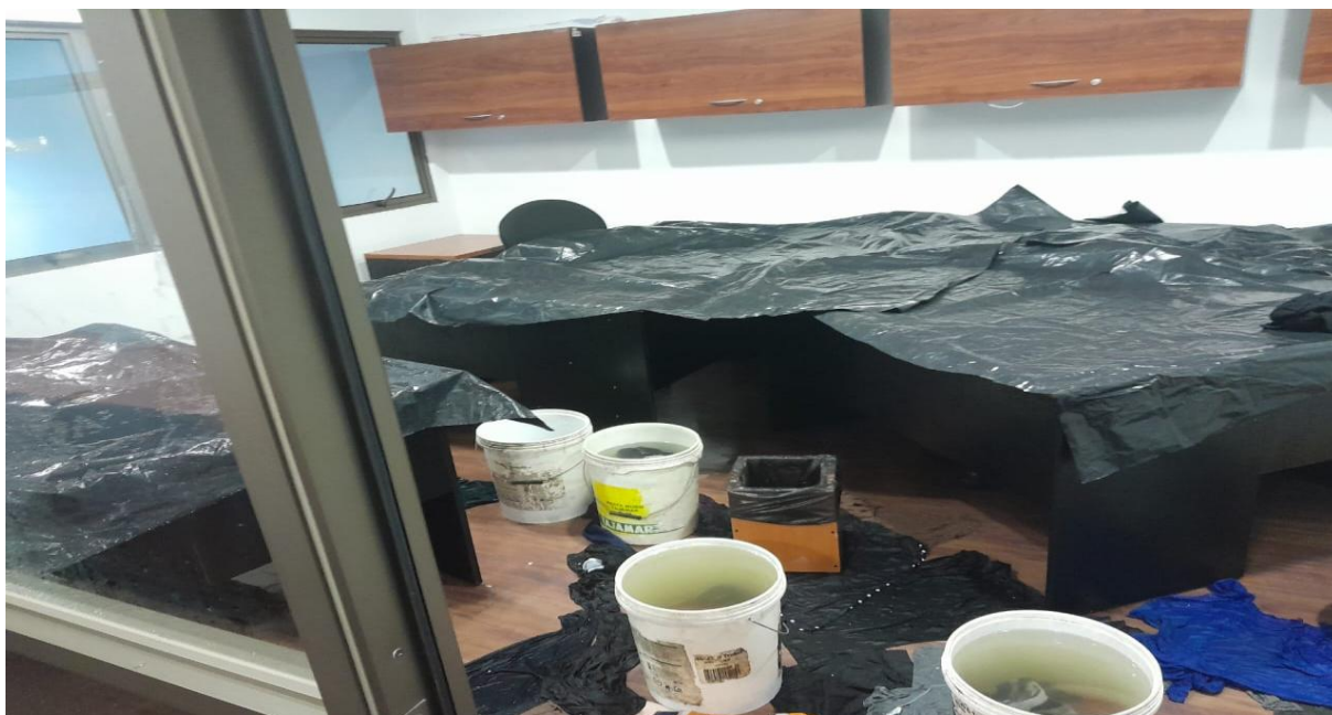
Imagen 21: Filtraciones Oficinas Doctorado de Matemáticas
