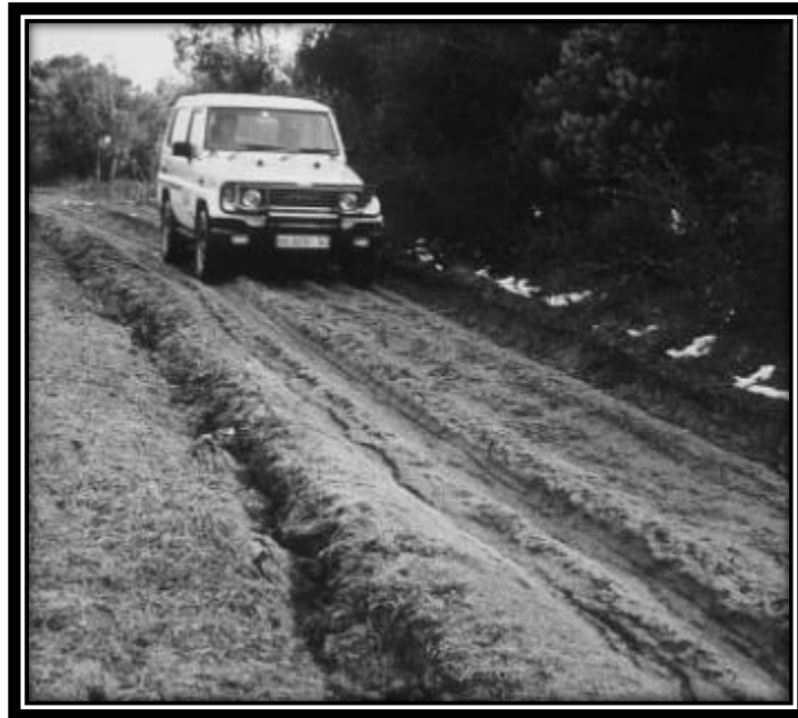
Figura 7-5: CAMINO FORESTAL CON ACUMULACIÓN DE SEDIMENTO. (Úbeda, 1996)
