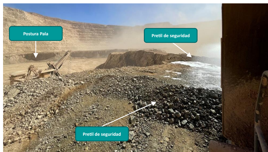
Figura 3.10: Plataformas mal diseñadas.
