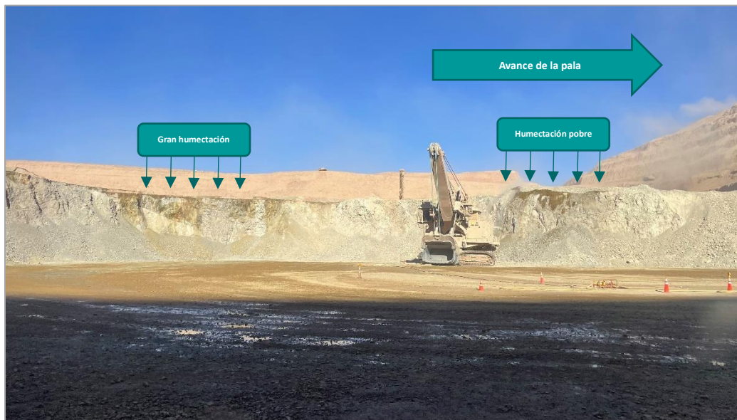
Figura 3.9: Desconexión aplicación del producto y avance del equipo de carguío.
