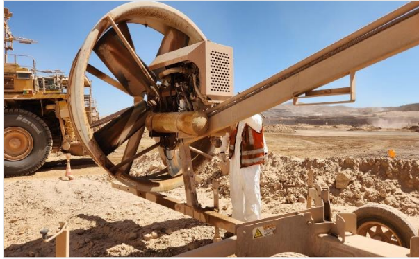
Figura 2.20: Ventilador Tow & Bow en chancador primario.
