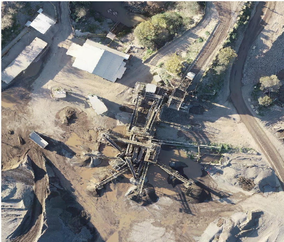
Ilustración 7: Foto mediante un dron de la planta de áridos Concón
