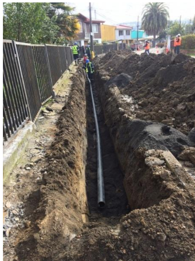
Ilustración 4-8, Tubería sobre cama de arena.
