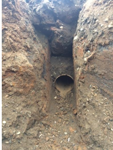
Ilustración 4-13, Tubería de acero como refuerzo en cruce de calzada.
