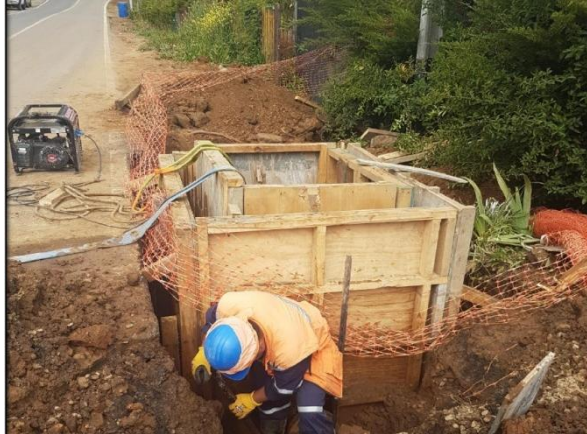
Ilustración 4-19; Moldajes de cámara de válvula.
