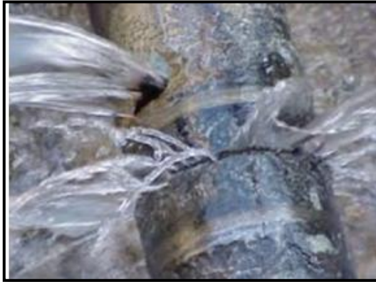
Ilustración 3-2, Perforación en matriz.
