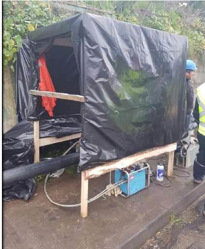
Ilustración 4-9, Carpa provisoria para realizar termofusión.
