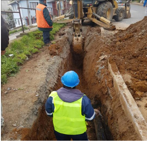
Ilustración 4-6, Excavación en acera.
