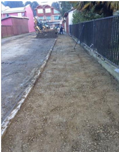
Ilustración 4-24, Base estabilizada compactada en aceras..
