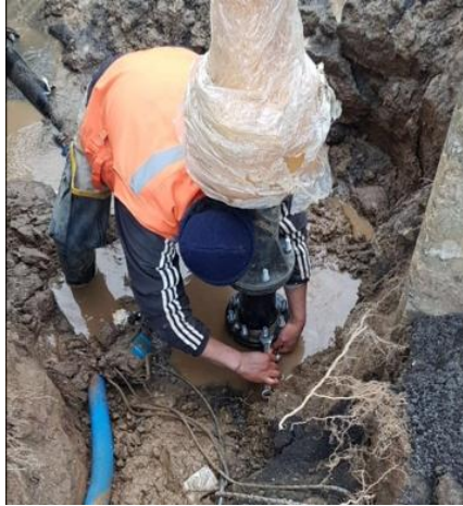
Ilustración 4-17, Instalación de grifo.
