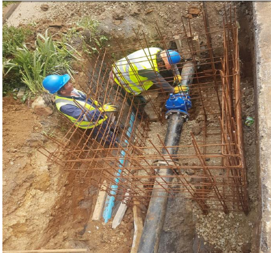
Ilustración 4-18, Enfierradura de cámara de válvula.
