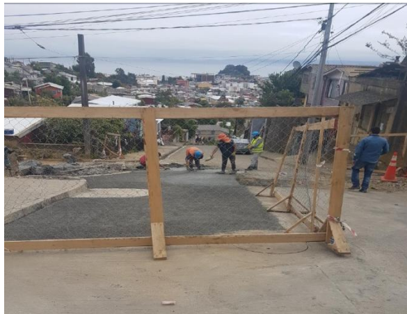
Ilustración 4-22, Cazada hormigonada, protegida con barreras duras. Fuente: Elaboración propia.
