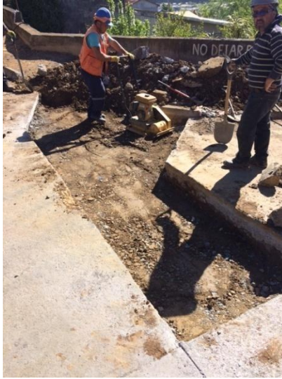
Ilustración 4-21, Compactación de base estabilizada para calzada. Fuente: Elaboración propia.
