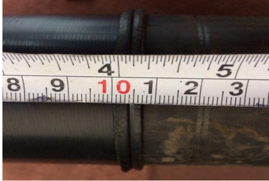
Ilustración 4-10, Control de formación de cordón de soldadura.
