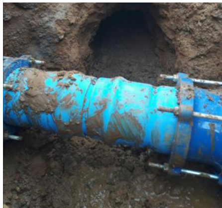
Ilustración 3-6, Reparación en matriz de Asbesto cemento.
