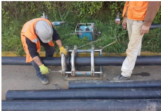
Ilustración 4-11, Operador alineando tubos, previo a fusión.
