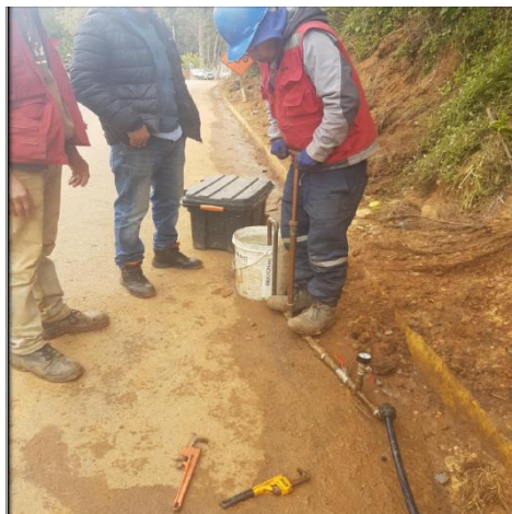
Ilustración 4-14, Operador con elemento para prueba de presión.
