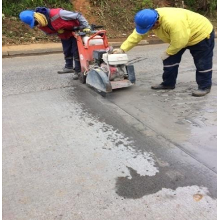
Ilustración 4-23, Corte de paño en calzada.
