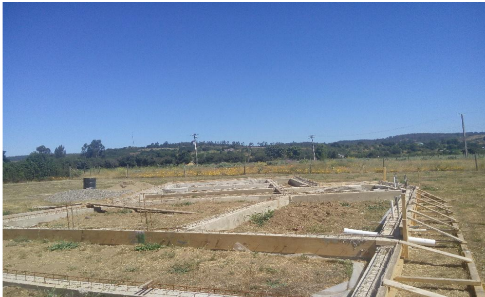
Figura 2- 35. Construcción de losa de casa de hormigón
