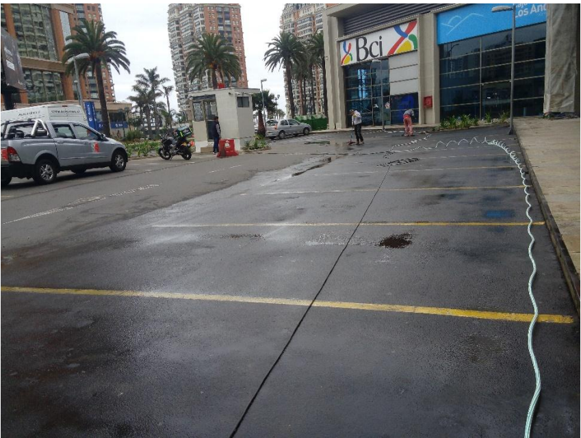
Fuente: Fotografía propia “Plaza Coraceros Strip Center”
