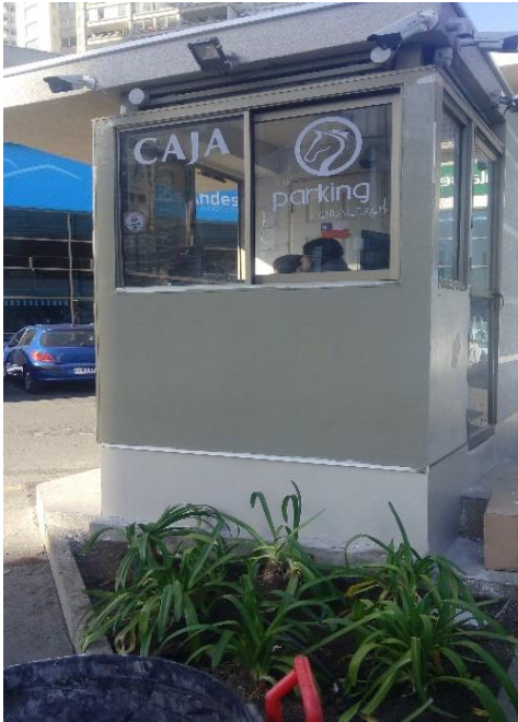
Fuente: Fotografía propia “Plaza Coraceros Strip Center”
