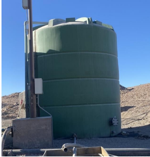
Figura 1-3.- Estanque de almacenamiento de agua industrial.
