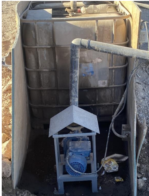
Figura 1-2.- Estanque de almacenamiento de agua mezclada con polvo químico.
