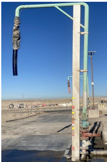
Figura 1-5.- Punto de recarga de agua para equipos de humectadores de terreno
