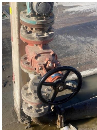
Figura 1-4.- Válvula de accionamiento manual para realizar el llenado de equipos humectadores de terreno.
