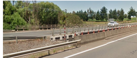
(b) Puente Chanco.
