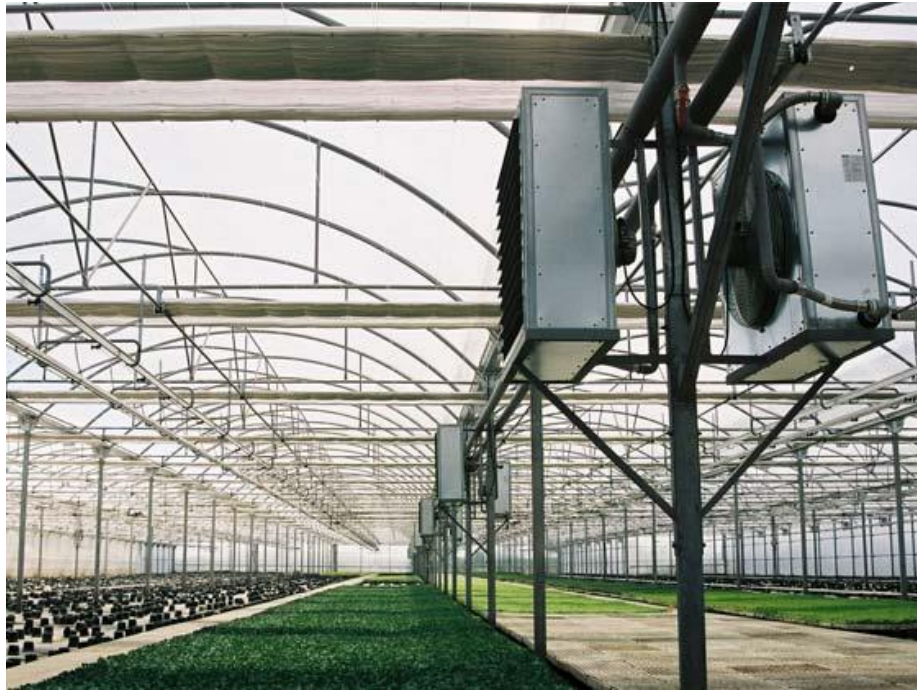
Ilustración 2-13 Sistema de calefacción
