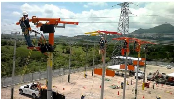
FIGURA 2-1: Trabajo de cambiado eléctrico
