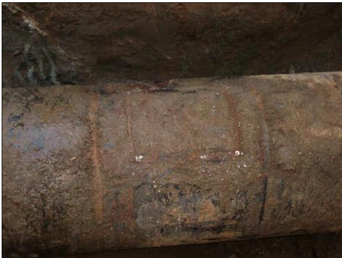
Figura 10: Cordón de soldadura en locación Anticlea
