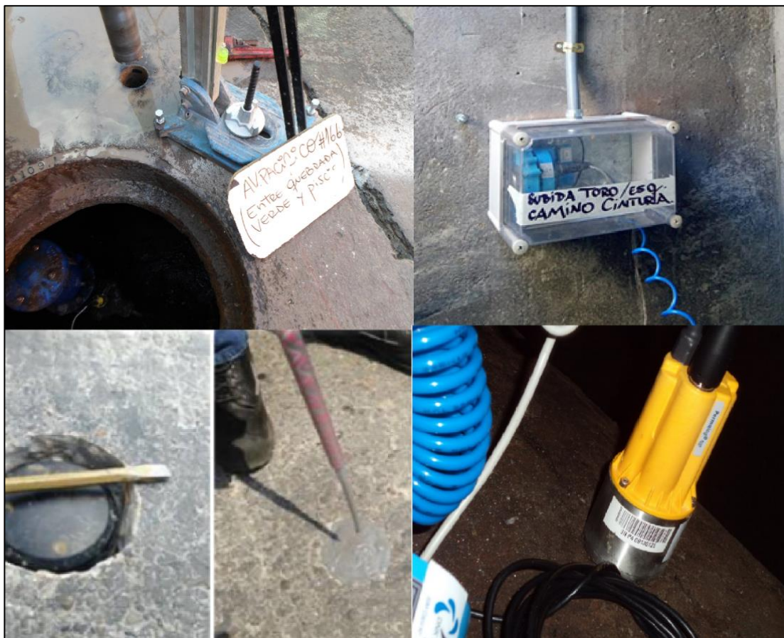
Figura 11: Instalación del sistema de monitoreo. Fuente: Elaboración propia
