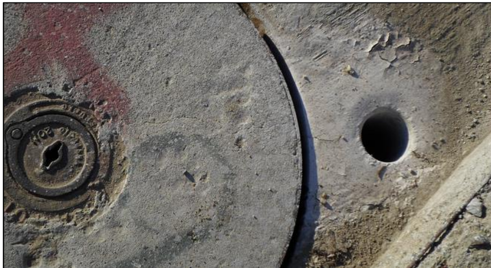
Figura 6: Perforación en locación Av. Alemania con calle Alemania, datalogger N°29. Fuente: Elaboración propia
