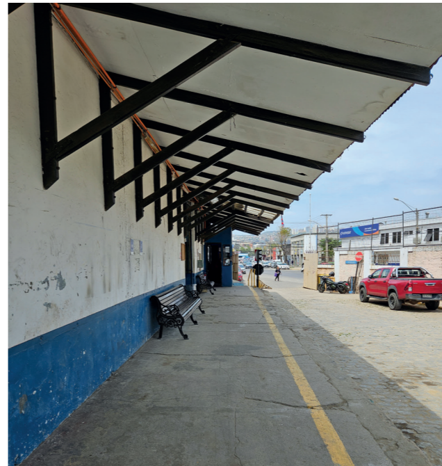
Figura 10. Fotografía pasillo exterior cuerpo A. Elaboración propia.
