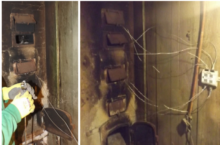
Figura 40: Instalación termocuplas cámara de combustión.
