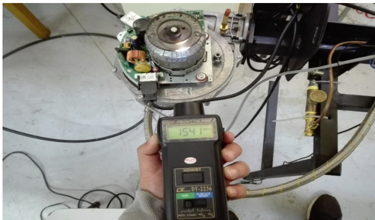
Figura 36: Medición RPM ventilador.
