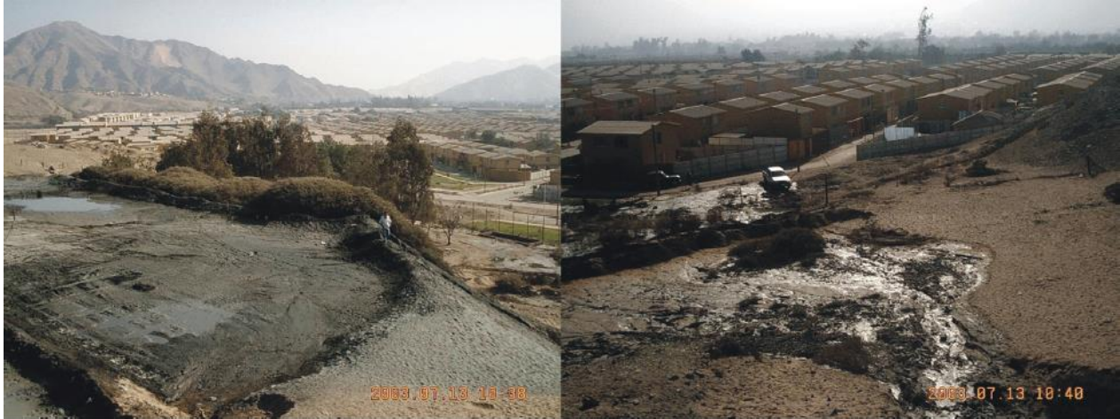
Ilustración 6: Incidente de overtopping: (izq.) retención del relave por parte del muro de contención; (der.) flujo de material aguas abajo (Villavicencio et al., 2014).
