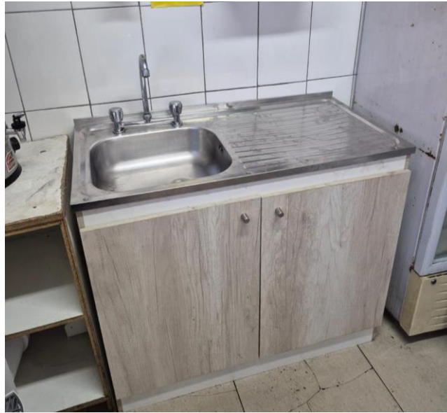
Figura 1-13: Fabricación e Instalación de mueble lavaplatos
