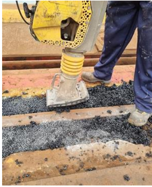
Figura 1-6: Confinamiento de rieles grúa STS
