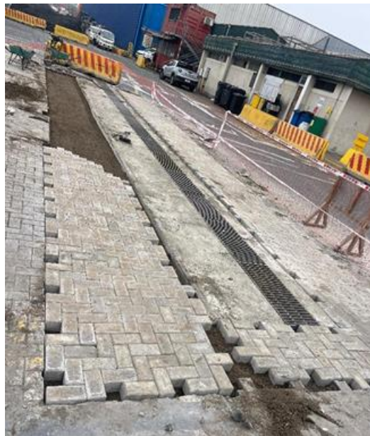
Figura 1-5: Reparación de pavimento y sumideros
