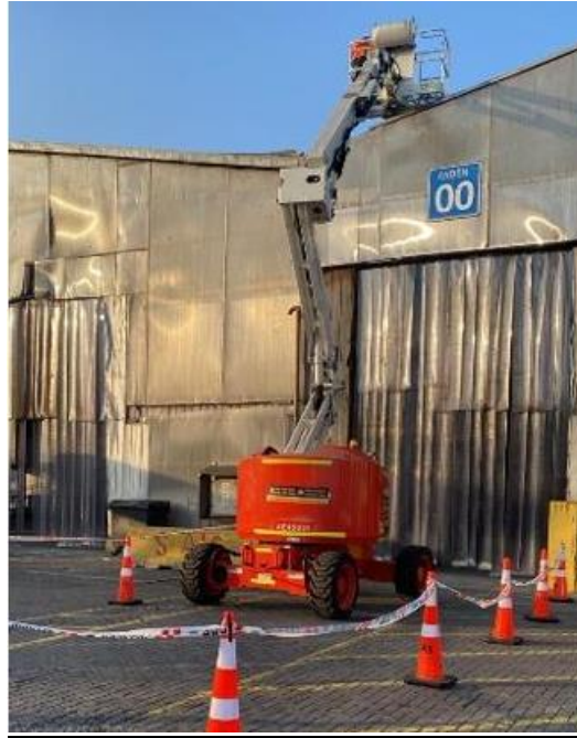
Figura 1-8: Trabajo en altura mediante Alza hombre
