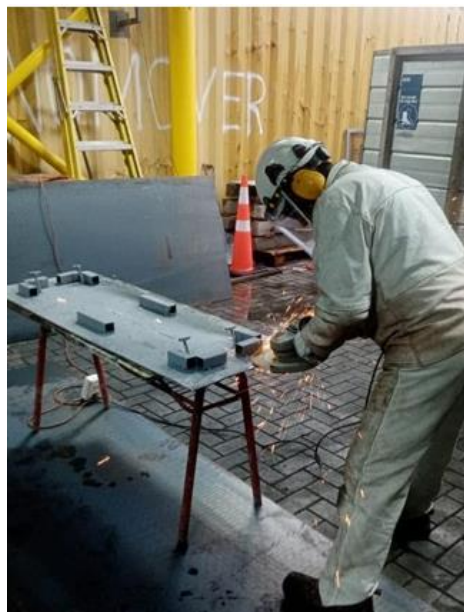
Figura 1-7: Corte de estructura metálica mediante esmeril angular.
