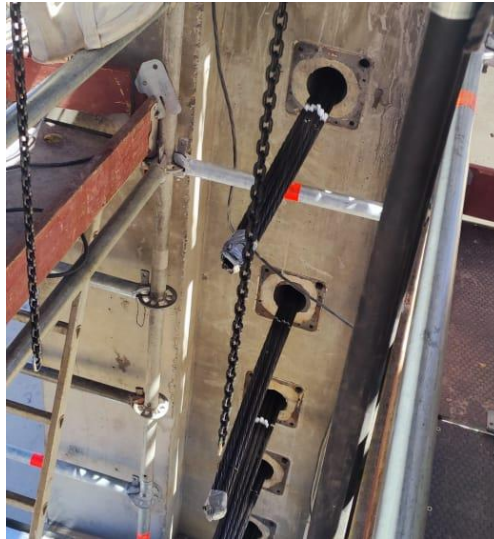
Imagen N°5 Enfiado de Cables.
