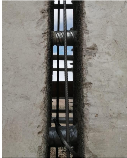
Imagen N°4 Instalación de Coplas y Sellos.
