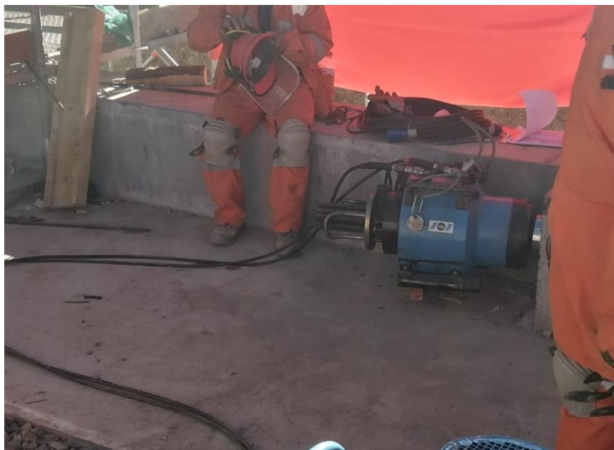
Imagen N°6 Instalación Equipo de Tensado.
