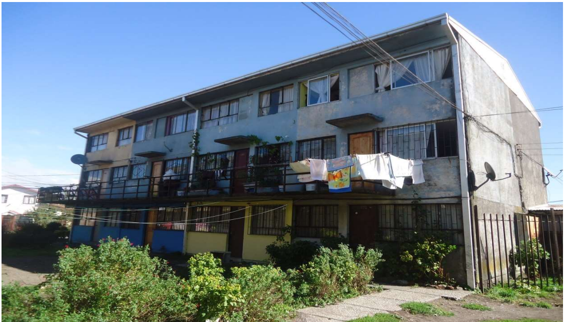
Figura 2-5: Foto Exterior del Block 518
