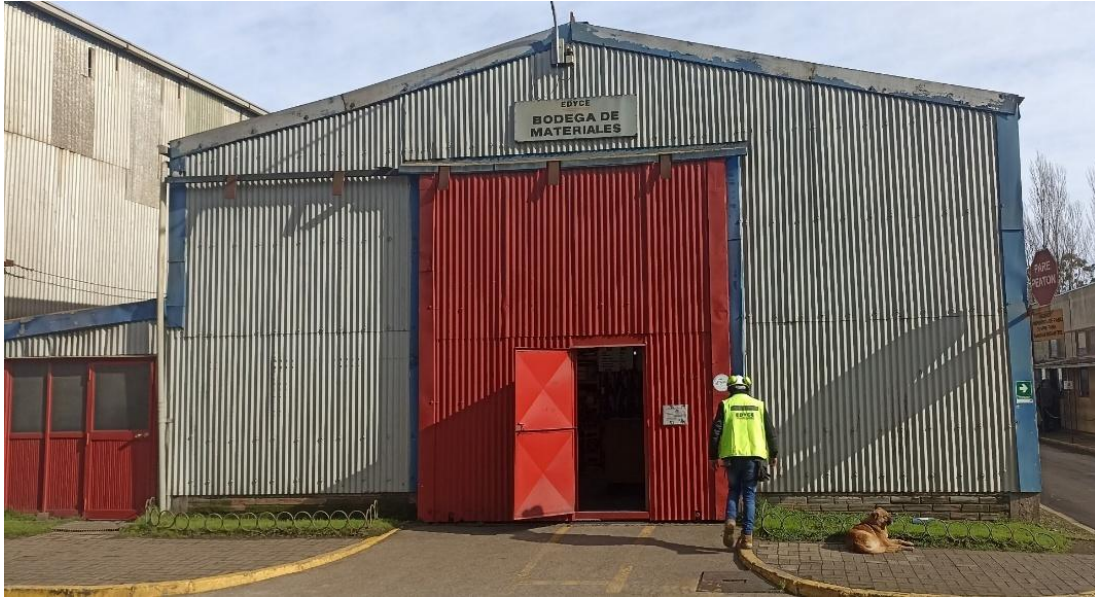
Imagen 1-1. Bodega de Materiales Edyce Metalúrgica. Fuente: Elaboración Propia.
