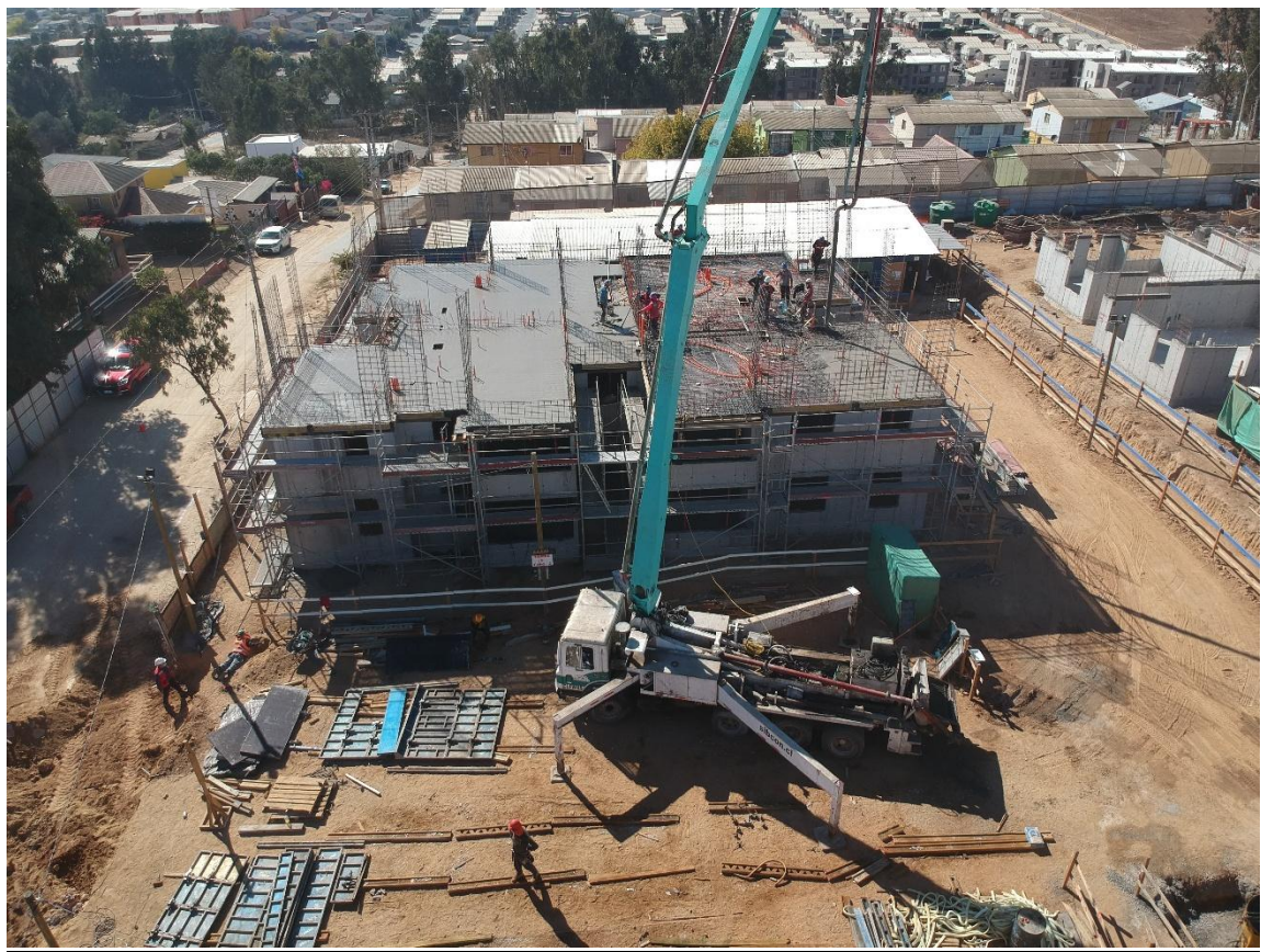
Figura A-16. Ejecución de losa y avances de estructura en obra gruesa.
