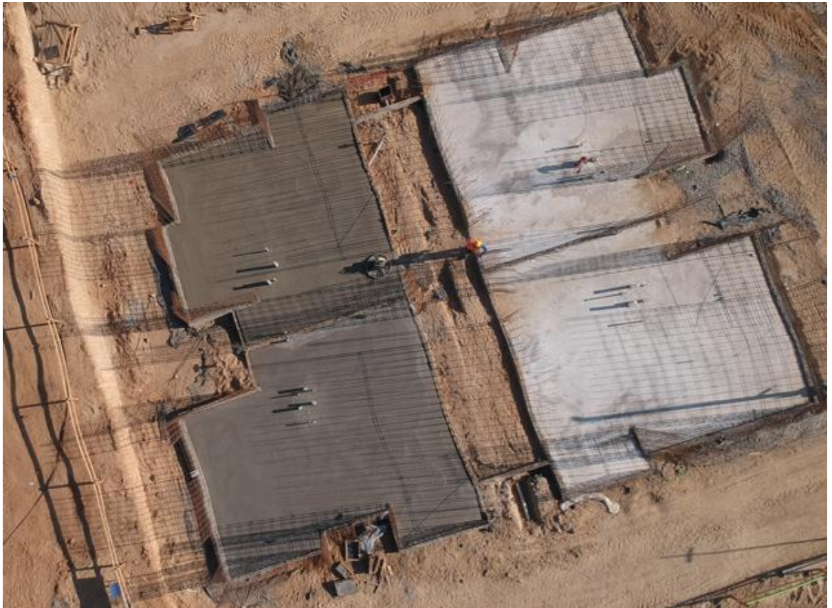
Figura A-14. Ejecución de fundaciones y hormigonado de elementos de base estructural.
