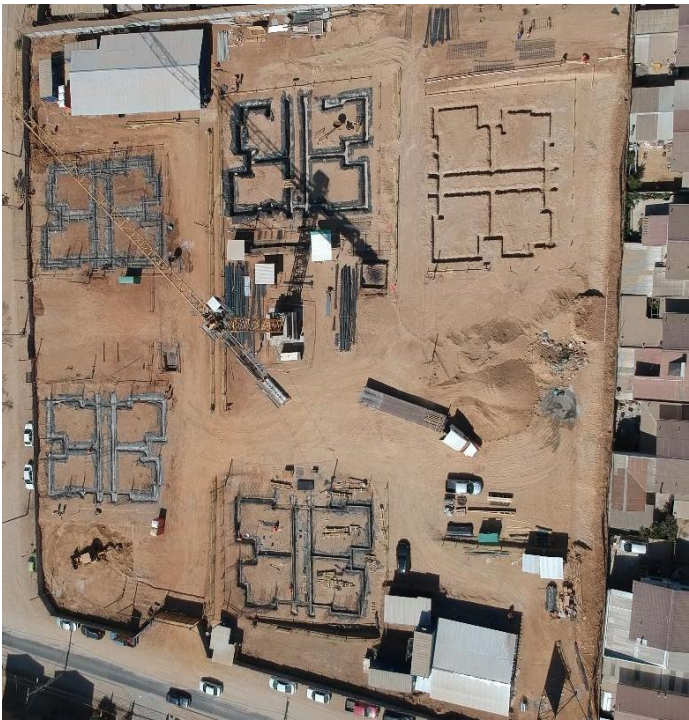
Registro fotográfico desde un dron con fecha 22 de enero 2021.
