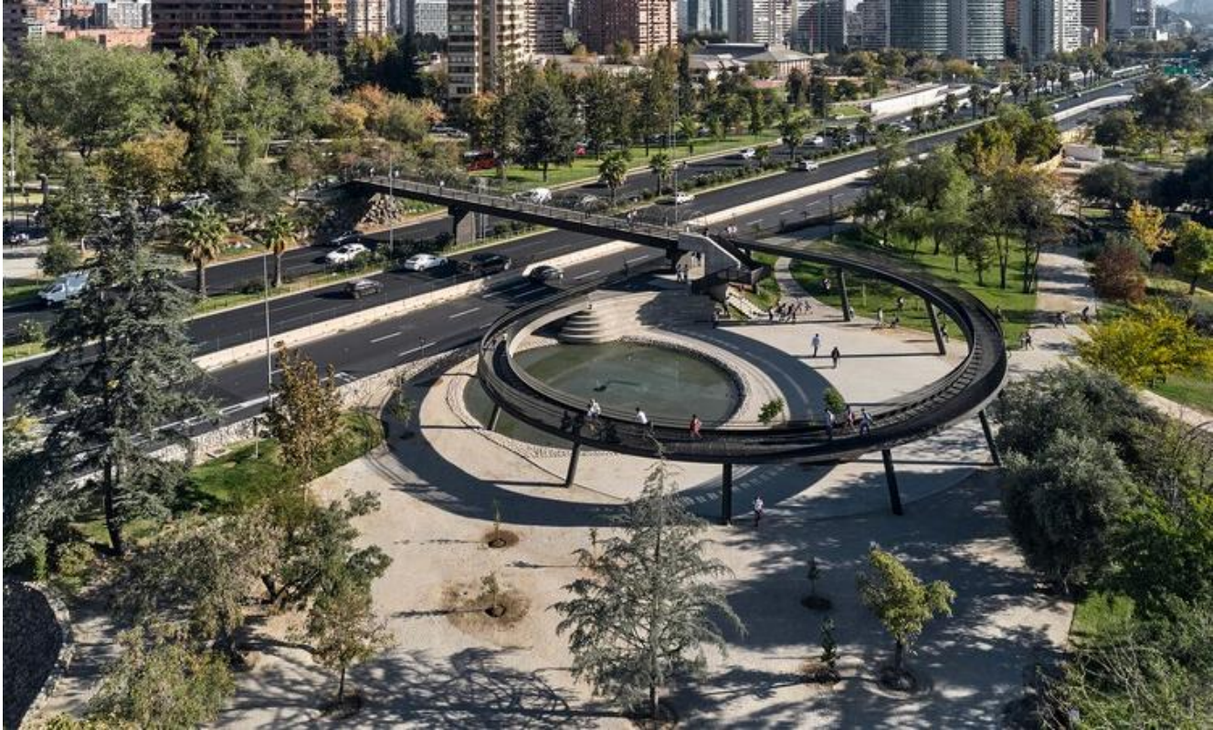
Imagen 4. Rampa Parque Cuauhtémoc
